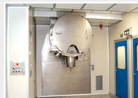
Монтаж системы PLANEX в чистом помещении
