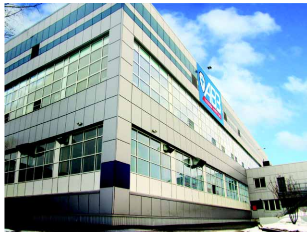
Здание производственной базы АВЗ-СП
