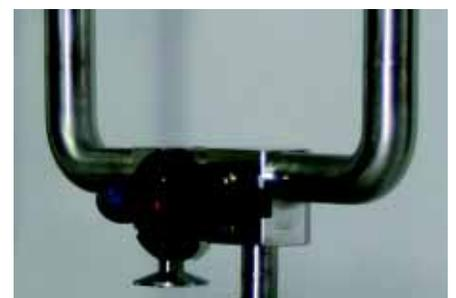
Рис. 17. Разборный клапан с нулевой застойной зоной. **Московский эндокринный завод.**
