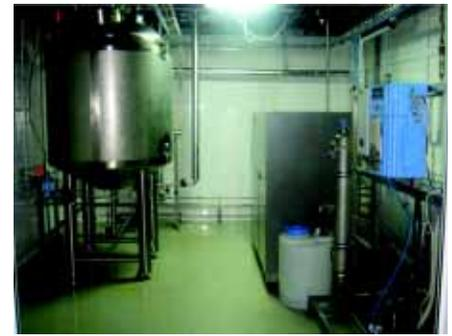
**Рис. 8. Система приготовления, хранения и распределения воды для инъекций/воды высокоочищенной с использованием установки Septron line 30 HPW. ОАО Биохимик, Саранск**
