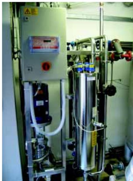
**Рис. 12.** УФ-стерилизатор BEWADES 390 P, ЗАО «ГЕДЕОН РИХТЕР-РУС»
