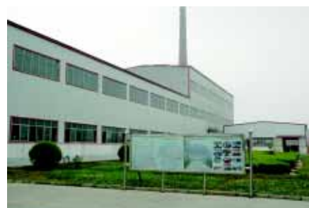
Проходная завода по производству стеклотрубки и флаконов
