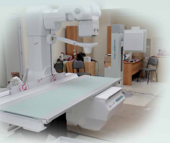
Монтаж телеуправляемого комплекса КРДЦ «МЕДИГРАФ» в рентгеновском кабинете
